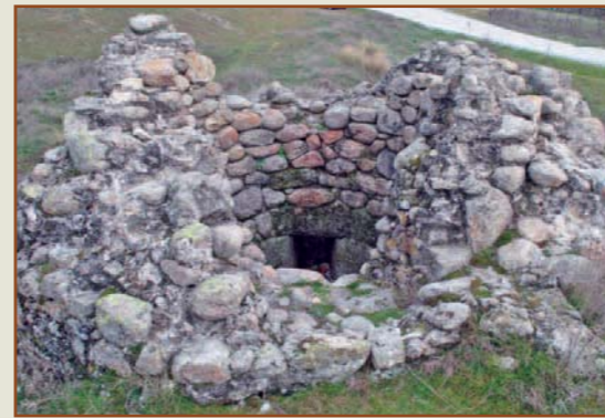
En nuestro caminar, descubriremos las pocas piedras de un antiguo molino hidráulico que aún sobreviven al paso del tiempo. De este Molinillo del papel sólo queda el cubo
