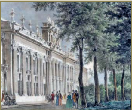
La historia del pozo de La Granja, nos retrotrae al siglo XVIII, al año 1735. La iniciativa de su construcción parte de la Corte, que visita con asiduidad el Palacio granjeño
