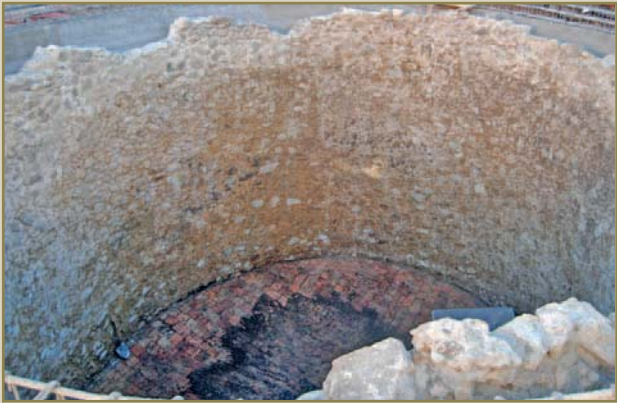
En una superficie de 200 m², aparecieron las primeras piedras de la mampostería más superficial que formaba las paredes de la estructura soterrada del pozo
